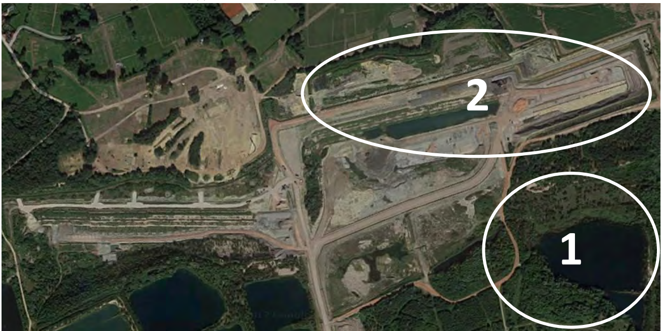
A. Overzicht van de oude (1) en nieuwe (2) locatie in de groeve waar verzameld kan worden.
